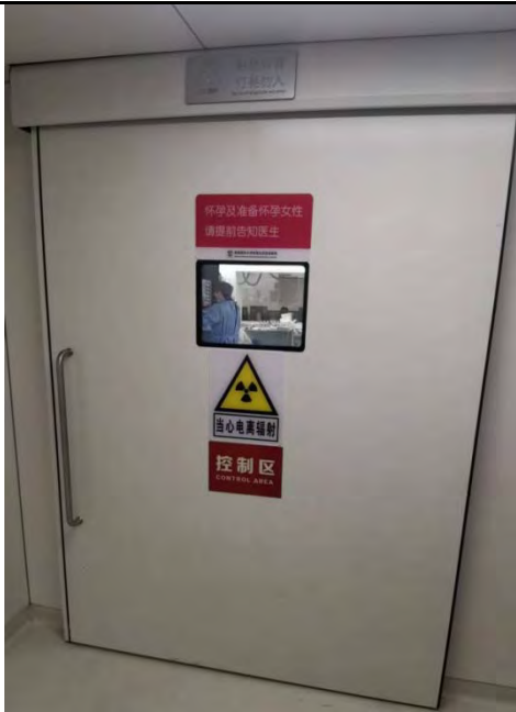
患者防护门外电离辐射警告标志和警示灯、分区标识
