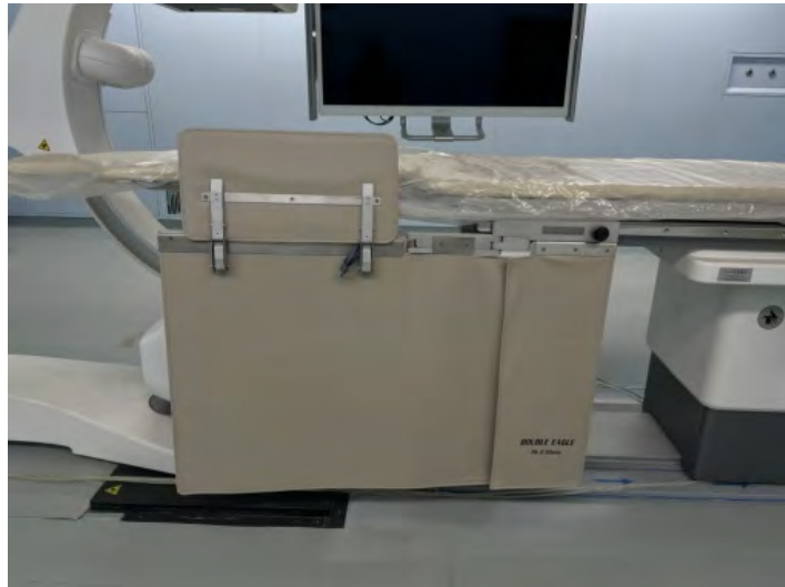
铅悬挂防护屏和床侧防护帘
